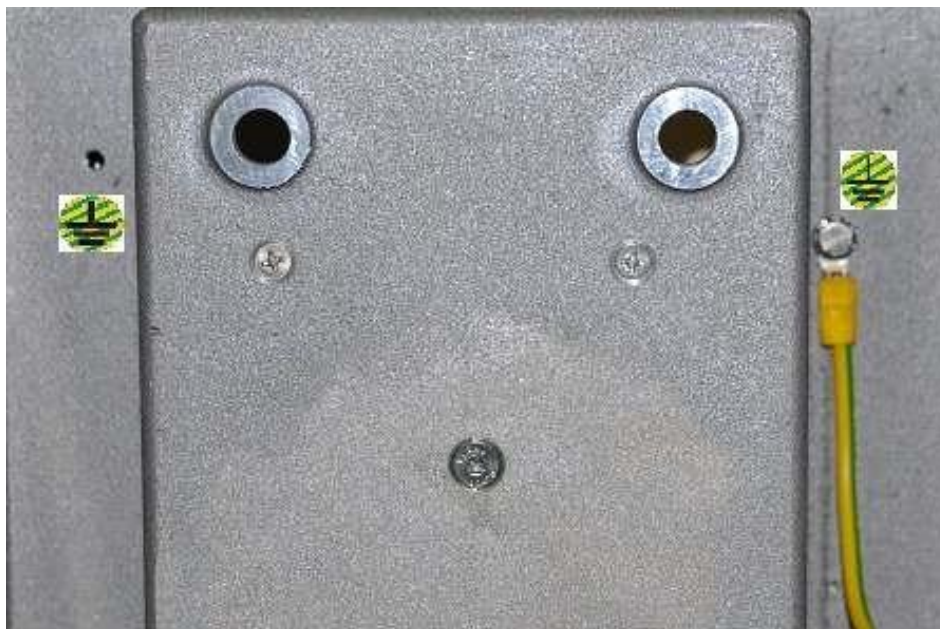
Anschluss der Erdung wahlweise links oder rechts
